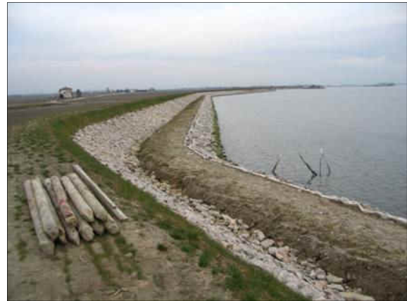
Argine a laguna a lavori ultimati (Latisana)
