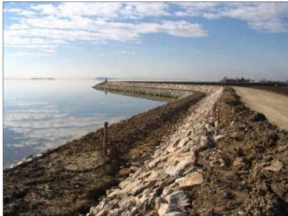
Argine a laguna in costruzione (Aquileia)
