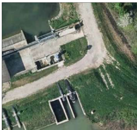
Idrovora Colomba Nuova (Carlino)
