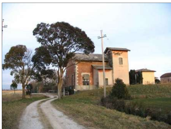
Idrovora Ca' Anfora Vecchia (Terzo d'Aquileia)
