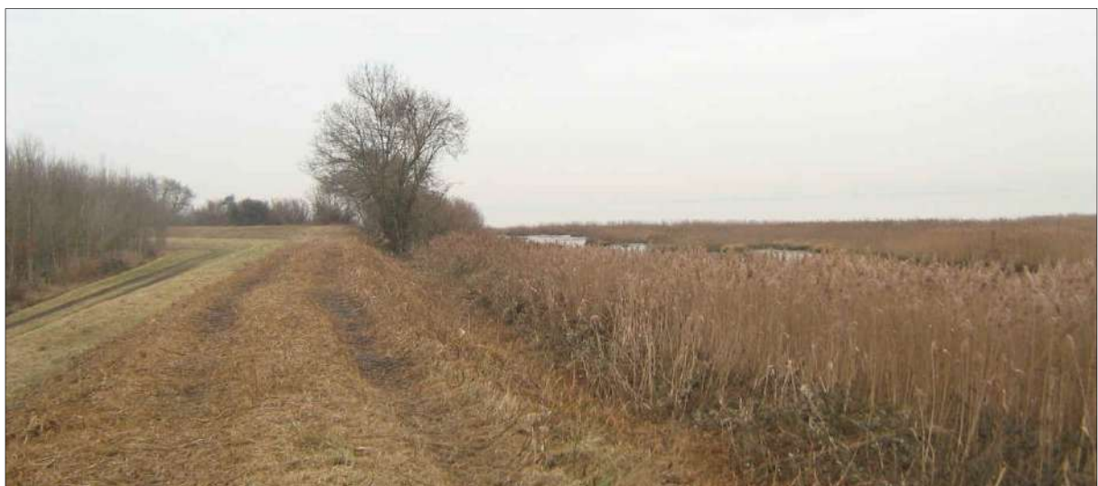
Vista dall'argine a mare presso l'idrovora Colomba: l'entroterra a sinistra e la laguna a destra
