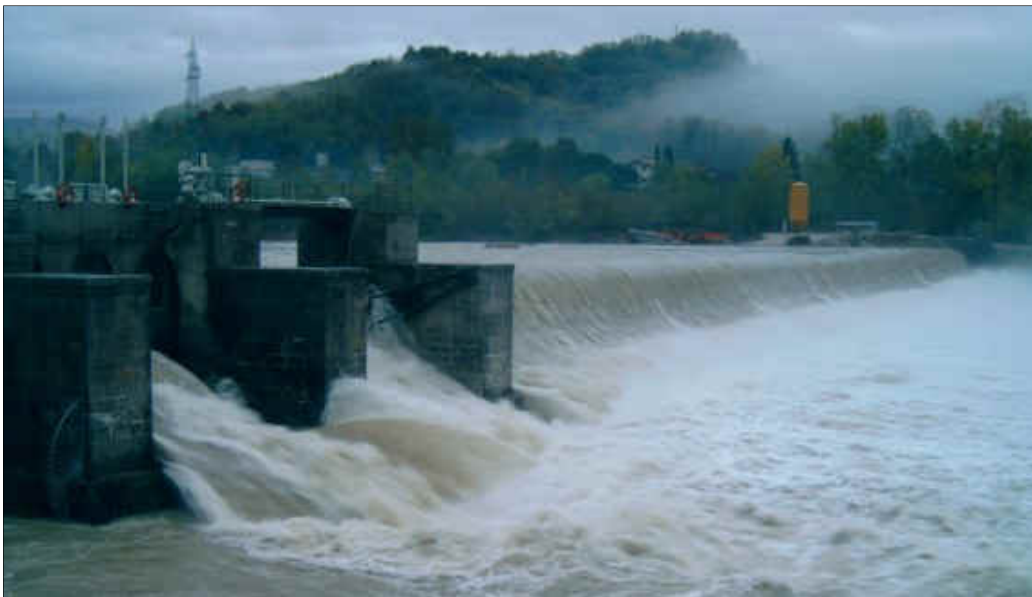
Piena del torrente Torre in corrispondenza della traversa a servizio della presa irrigua di Zompitta
