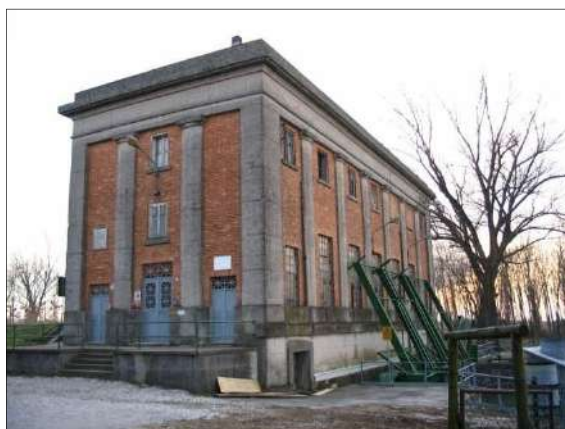
Idrovora Ca' Anfora Nuova (Terzo d'Aquileia)
