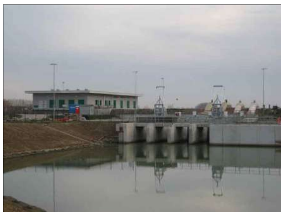
Idrovora Planais Nuova (San Giorgio di Nogaro)
