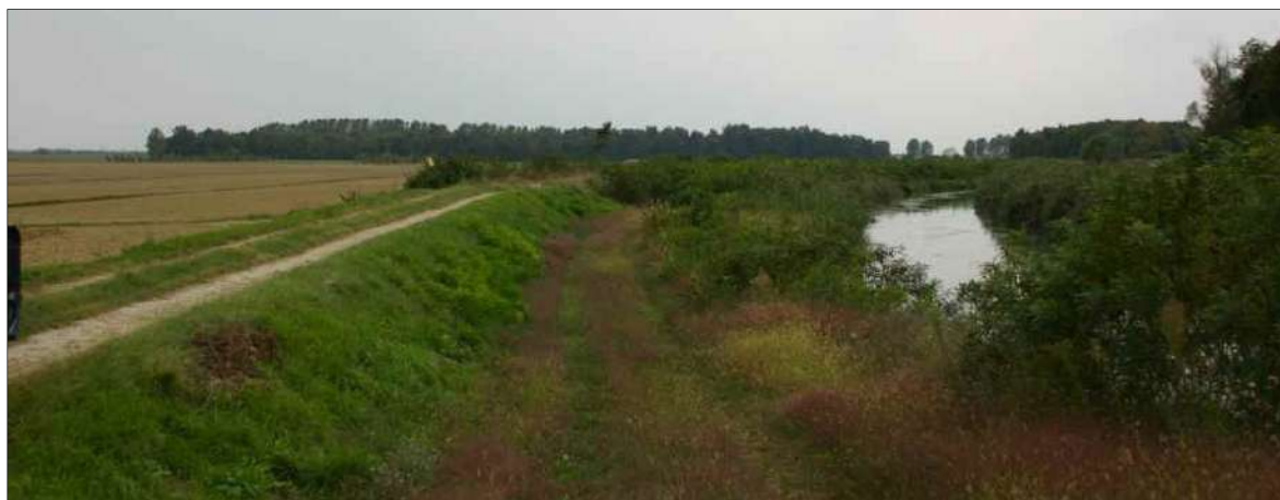
A sinistra, l'area agricola del distretto Carlino pluvirriguo, con derivazione dal Canale Cormòr
