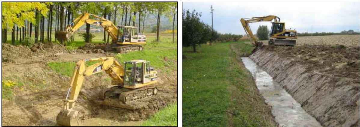
Espurghi di canali di scolo con escavatori
