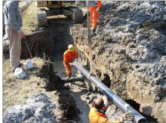
Pompe e tubazioni di mandata di una stazione di pompaggio e la posa una condotta irrigua in PVC
