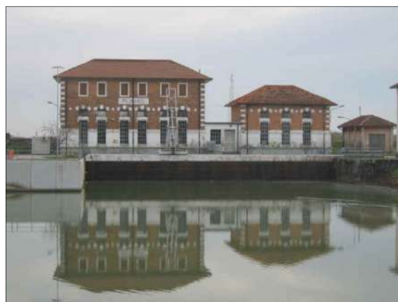
Idrovora Planais Vecchia (San Giorgio di Nogaro)
