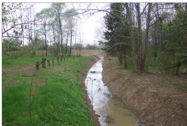
Sistemazione idraulica di un canale di scolo
