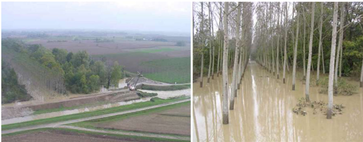
Immagine aerea del manufatto di scarico (sinistra) e dettaglio dell'area allagata del bacino di laminazione (destra), durante un evento di piena
