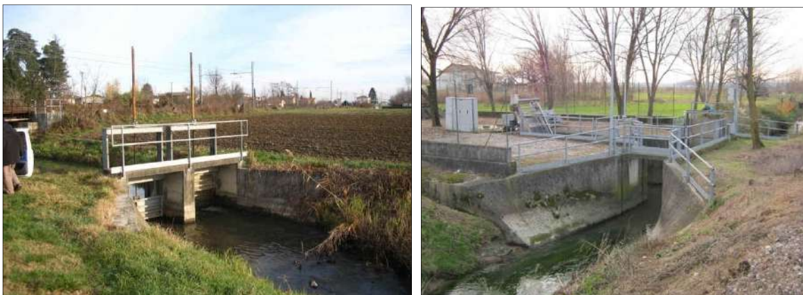
Derivazione con traversa fissa sul canale Muzzanella e postazione di sollevamento
