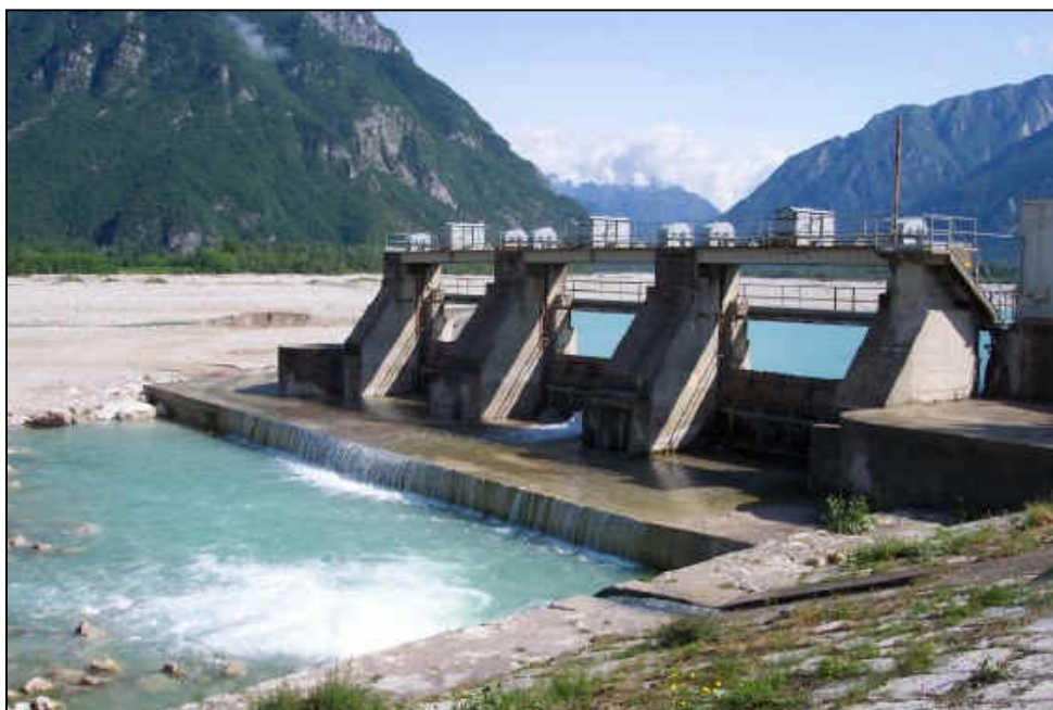
Particolare della traversa sul fiume Tagliamento presso l'opera di presa di Ospedaletto, munita di paratoie di regolazione
