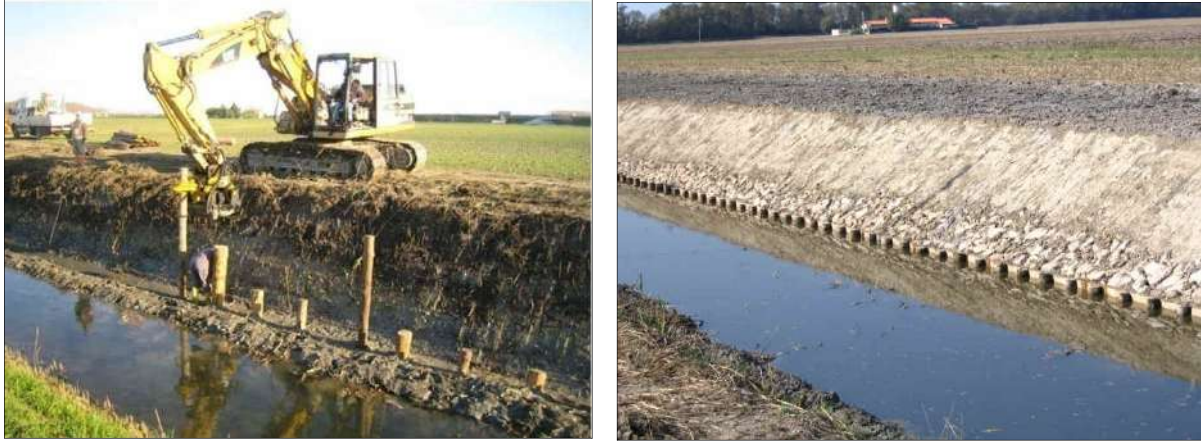
Riprese di pali: infissione di pali al piede e posa del geotessuto e pietrame di cava
