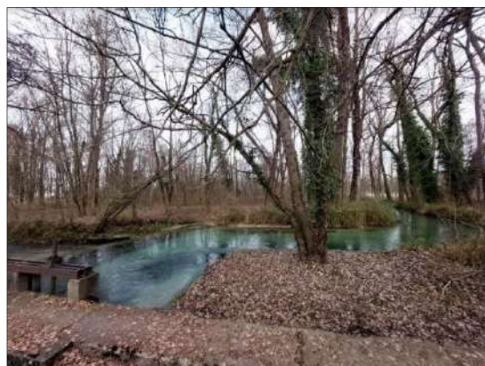
Canale adduttore: dalla presa sul fiume Tagliamento alla derivazione in località Villanova di Carpacco
