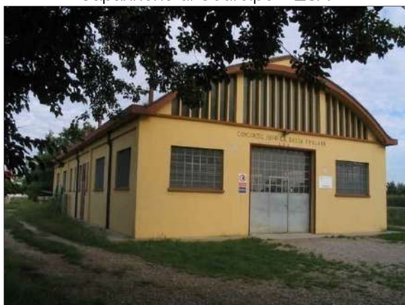
Capannone di Talmassons - ZSA
