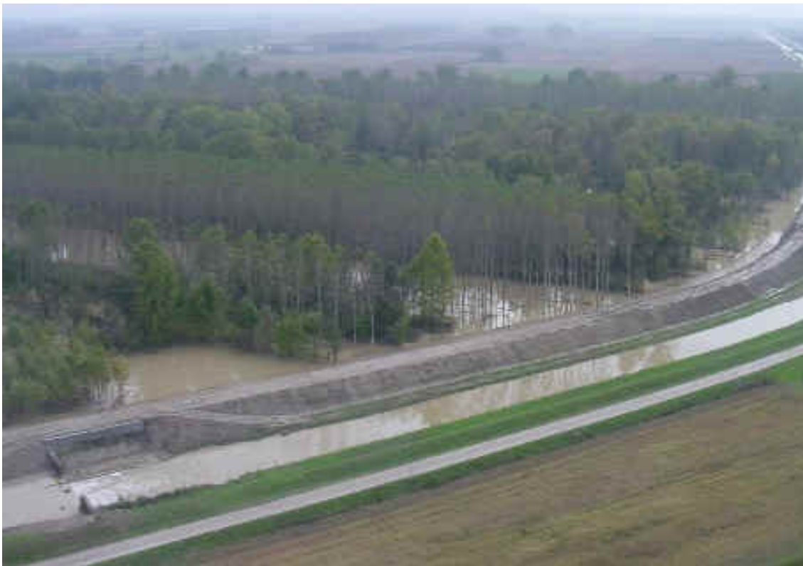
Immagine aerea del bacino di laminazione e del manufatto di sfioro a monte dell' manufatto di scarico, durante un evento di piena
