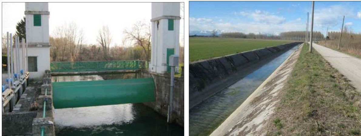
Derivazione del Varmo e collettore irriguo del Varmo (Comune di Varmo)
