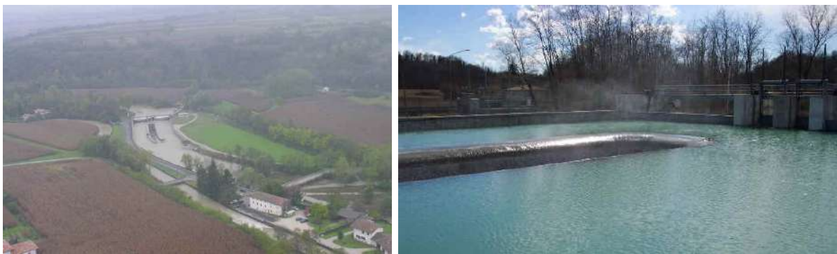
Immagine aerea del nodo idraulico di San Mauro - Rive d'Arcano - e dello scolmatore sul torrente Corno durante un evento di piena (sinistra) e dettaglio del manufatto scolmatore in condizione di normale deflusso (destra)
