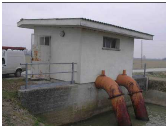
Idrovora Pudliesa (Carlino)
