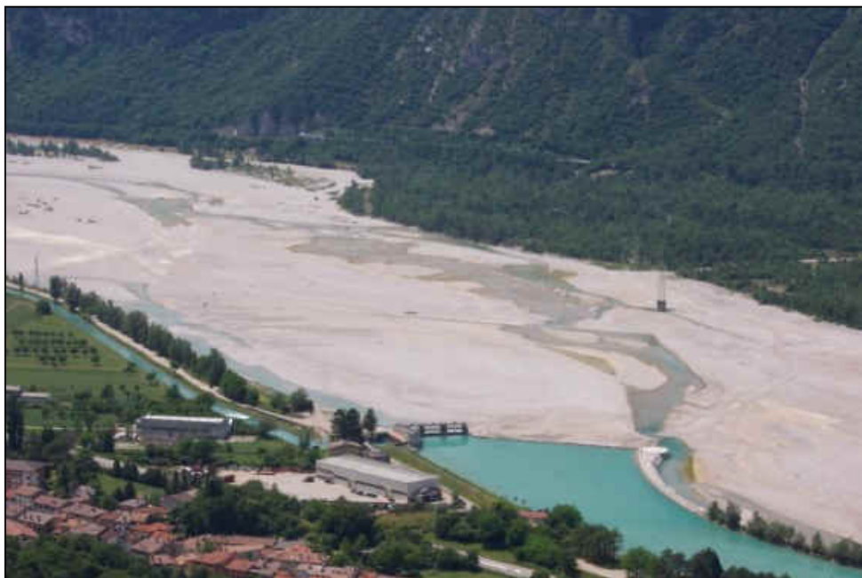
Vista panoramica dell'opera di presa di Ospedaletto sul fiume Tagliamento. A sinistra è riconoscibile il primo tratto del canale sussidiario irriguo
