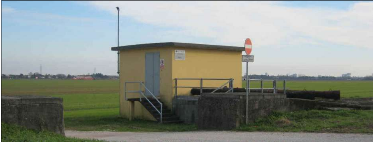
Impianto Volton irriguo (Latisana)
