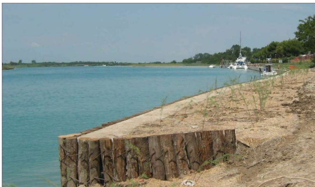
Arginature a lato della foce del fiume Tagliamento (Lignano Sabbiadoro)
