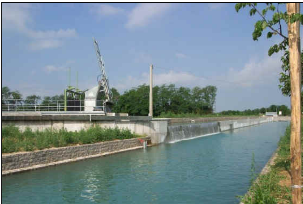
Particolare della presa della condotta di Basiliano dal canale irriguo principale Ledra - Tagliamento
