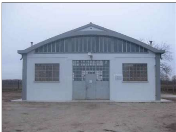
Capannone di Codroipo – ZSA
