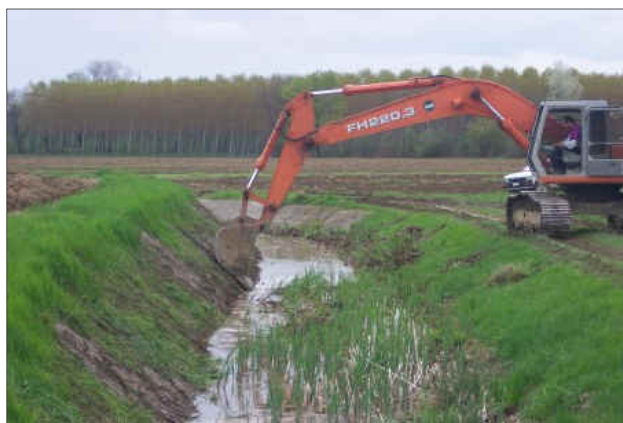
Lavori di espurgo e risagomatura di un canale di scolo
