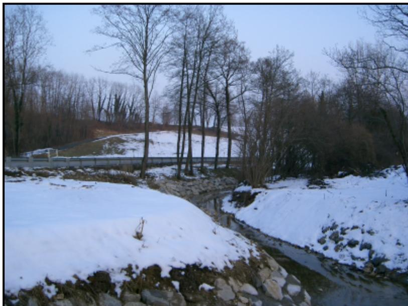
Figura 18: Vista invernale del Rio Bevorchiana, nel bacino del Torrente Cormôr, dopo l'intervento di sistemazione delle sponde con presidio a massi
