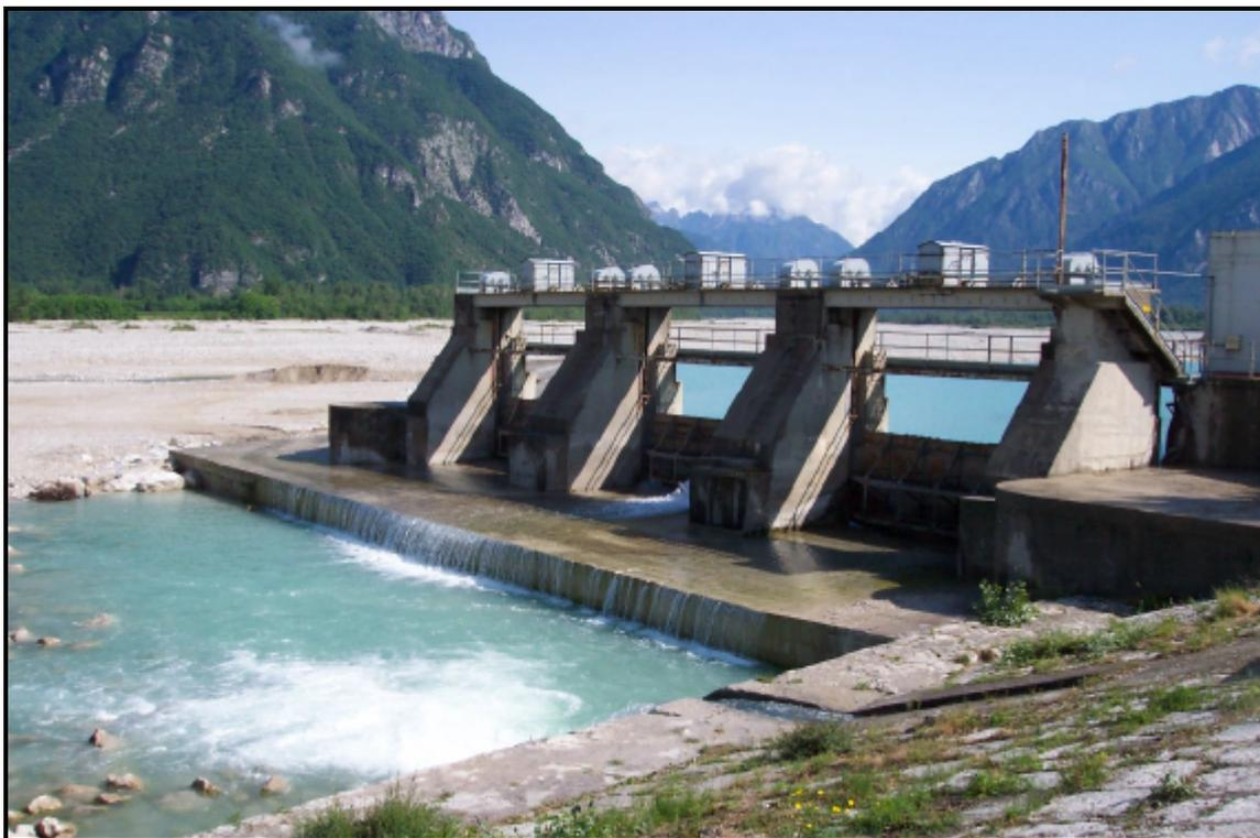
Figura 23. Particolare della traversa sul fiume Tagliamento presso l'opera di presa di Ospedaletto, munita di paratoie di regolazione
