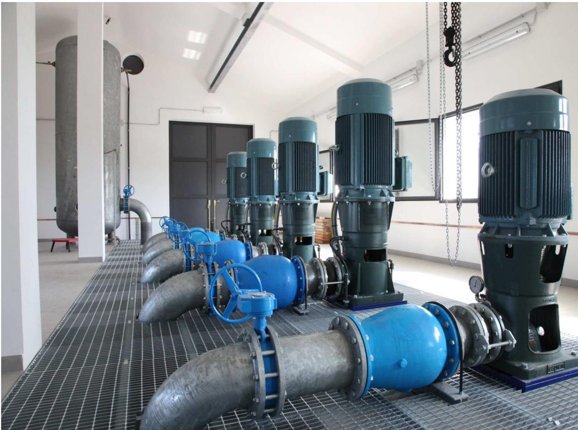
*Impianto di irrigazione ad aspersione con derivazione da canale e pompaggio da vasca*
