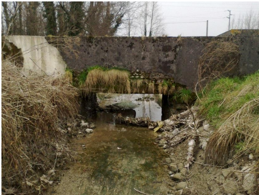
Figura 6 Canale di Gavons - Roggia di Carpacco, nodo idraulico e ponte canale
