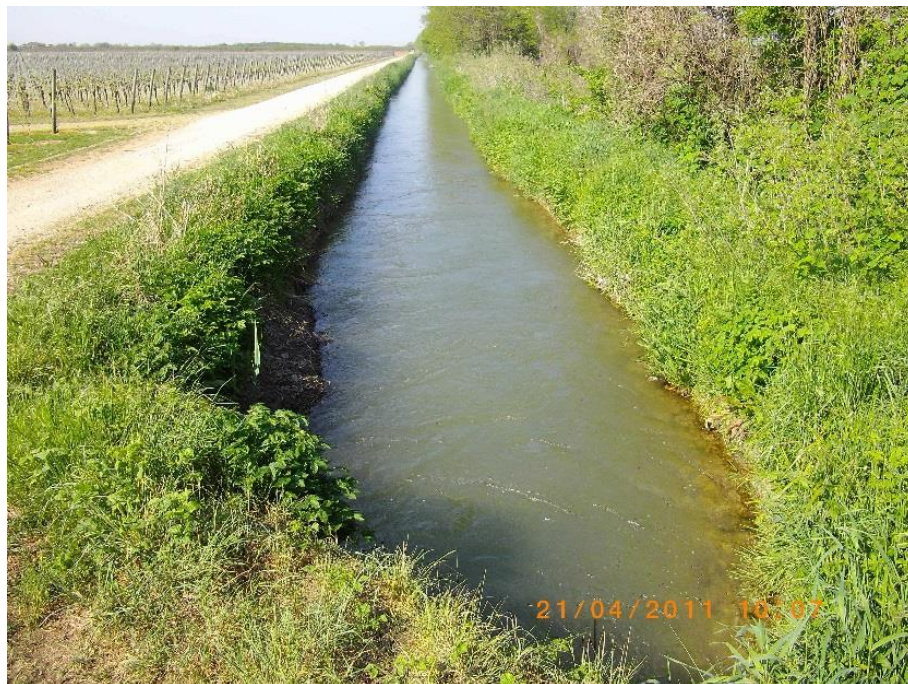
Figura 5 Canale di Rivolto, tratta oggetto di intervento che affianca la rete ferroviaria
