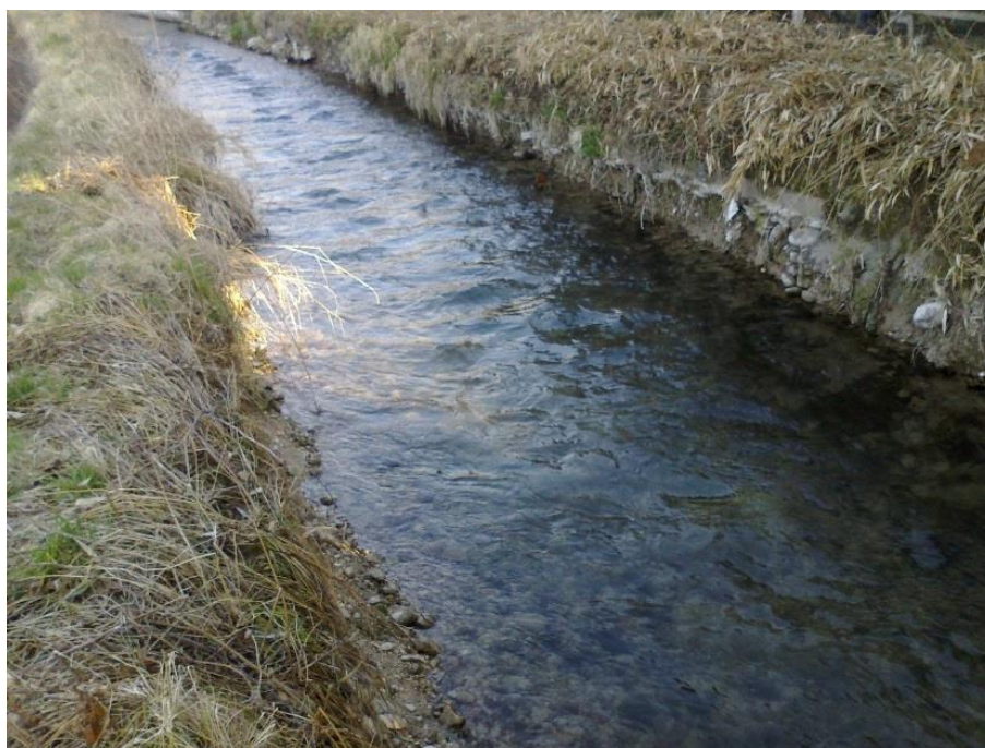
Figura 4 Canale di San Lorenzo, tratta oggetto di intervento
