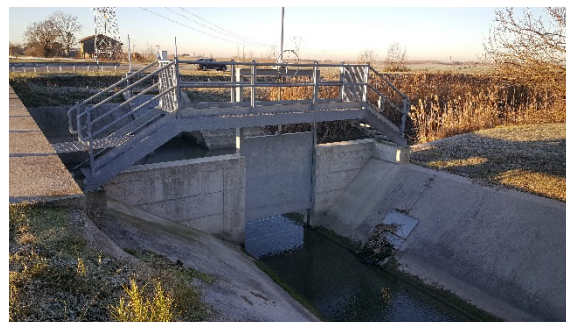
Foto di una paratoia per scarico laterale
