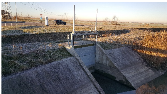
Foto di una paratoia con attraversamento
